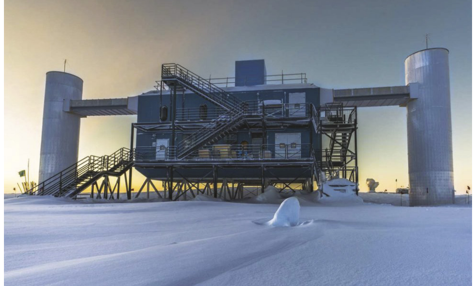
الشكل 8: مركز عمليات للكاشف IceCube المسمى «Lab» الموجود بالضبط فوق القطب الجنوبي. يتم دفن الوحدات الضوئية PMT التي تُشكّل الكاشف نفسه في الجليد إلى حدّ وصوله إلى القشرة الصلبة على عمق حوالي 2500 متر.
